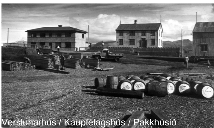
Verslunarhús / Kaupfélagshús / Pakkhúsið
